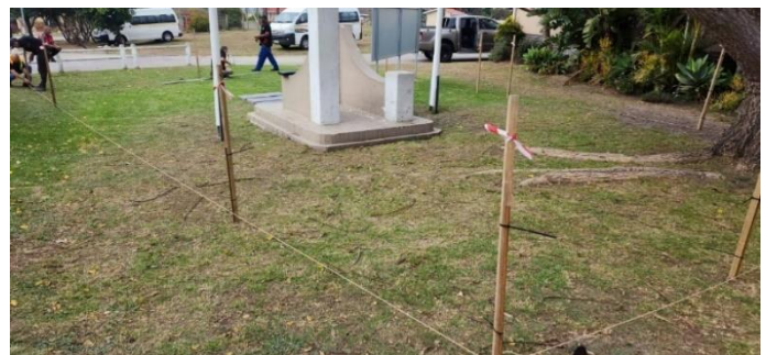
Uitlê van fundamente / Setting out foundations
