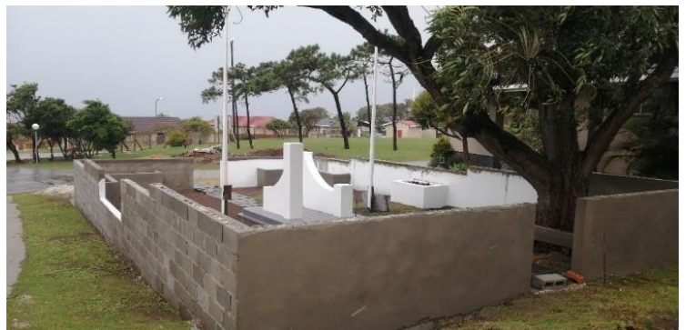
Pleisterwerk / Plaster work
