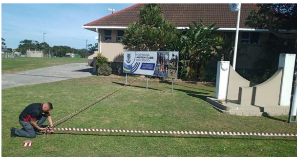
Uitlê van fundamente / Setting out foundations
