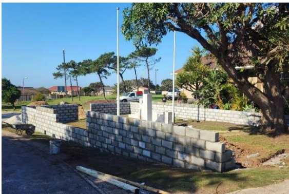
Bouwerk aan mure / Building walls
