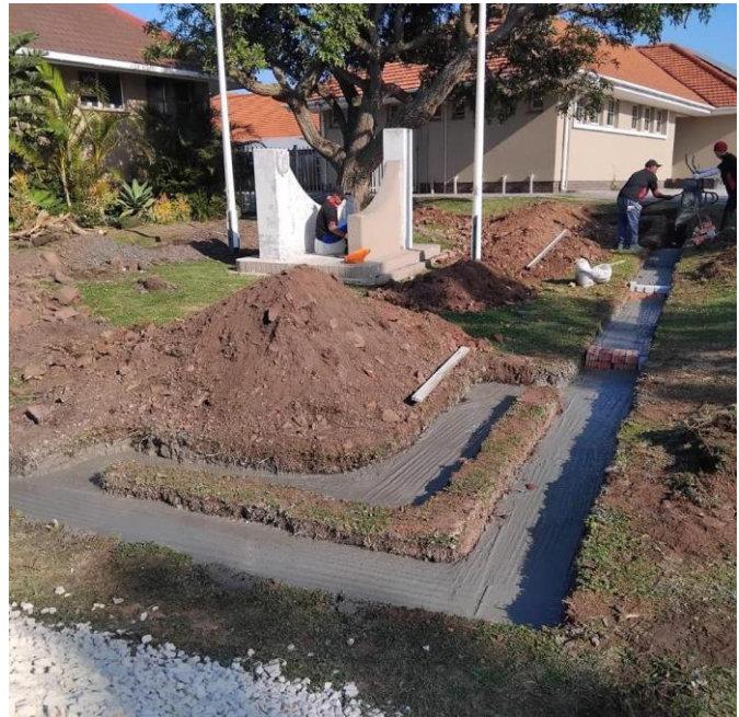
Betonfondamente / Concrete foundations
